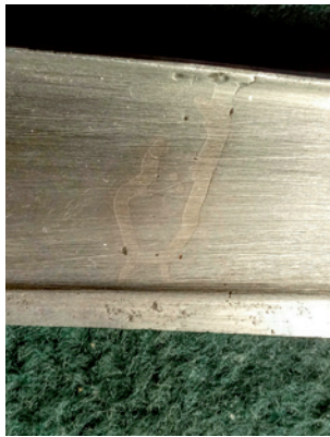
Fot. 4. Wyrównanie spoin
